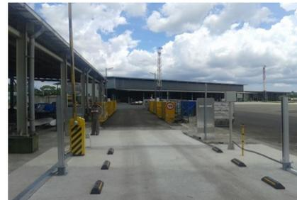
**Circuitos de inspección integral para las cargas aéreas el cual se compone de control radiológico de cargas paletizadas en movimiento, para las cargas de exportación y el sistema detección material radiactivo con su centro de monitoreo.**
